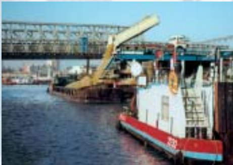
Am Berliner Spreebogen, bei der Verladung von Bodenaushub kam eine spezielle LKW-Kipprampe zum Einsatz.
