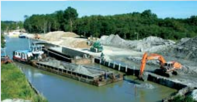
Am Berliner Spreebogen, bei der Verladung von Bodenaushub kam eine spezielle LKW-Kipprampe zum Einsatz.
