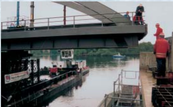
DBR-Schiffstechnik beim Einschwimmen einer an Land vorgefertigten Eisenbahn-Brücke mit 450 t Stückgewicht in Potsdam.
